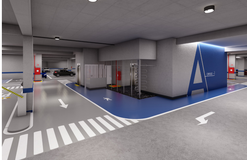
Edifício Genesis (Comercial), Anápolis - Engecom Construtora
