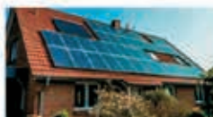
ENERGIA SOLAR FOTOVOLTAICA
