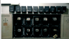
AUMENTO DE CARGA E MODERNIZAÇÃO DE PCs
