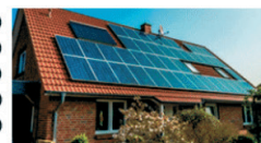
ENERGIA SOLAR FOTOVOLTAICA
