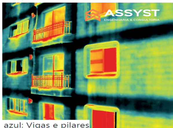
Inspeção de fachada realizada com DRONE com câmera termográfica
